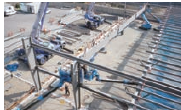
(写真上) 計算上の強度を確保している、実証実験は欠かせない。部材の「曲げ耐力」試験の様子。(写真中) 梁の耐力を検証する、全体フレームの漸増荷重実験。(写真下) 大スパンを得意とするyess建築は、大きなクレーン車が2台入ってもまだまだ余裕がある
